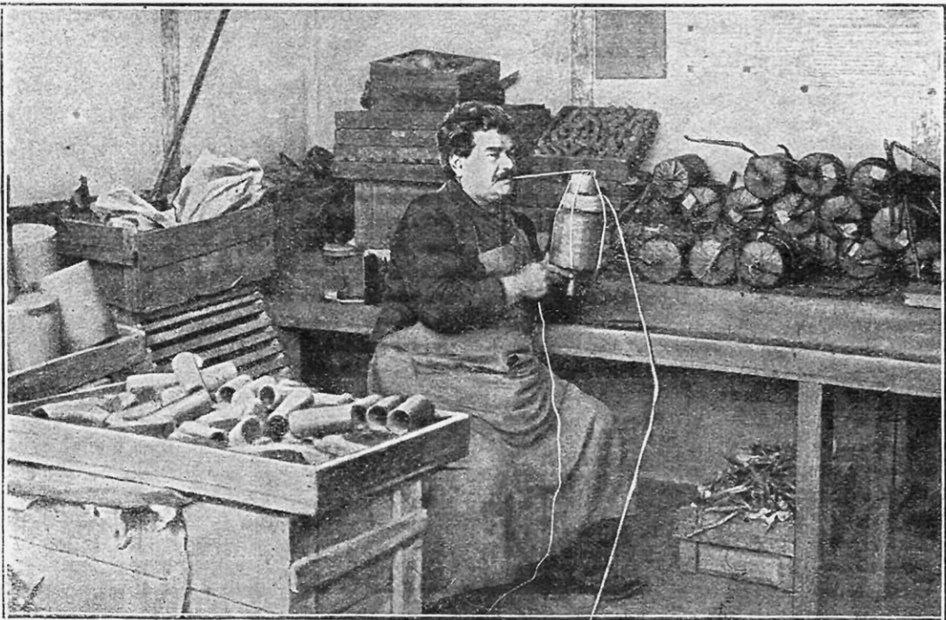
OUVRIER PROCÉDANT AU MONTAGE D'UNE GROSSE BOMBE A PARACHUTE Il comprime fortement à l'aide d'une solide ficelle les divers éléments qui constituent l'engin.
