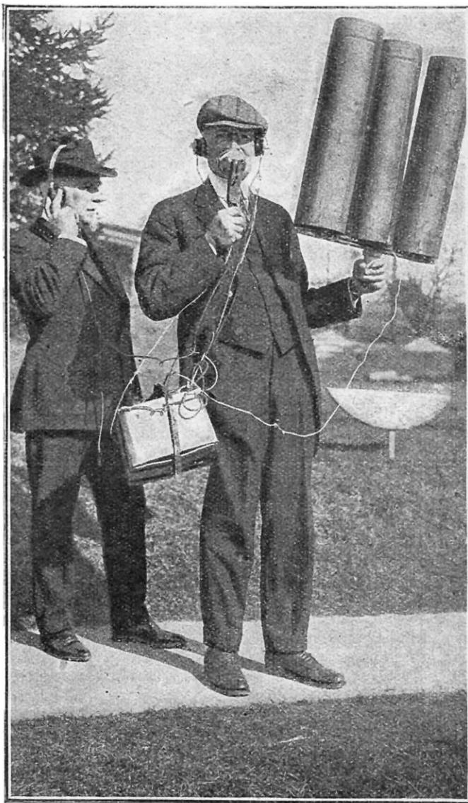
CONVERSATION RADIOTÉLÉPHONIQUE FAITE EN MARCHANT M. Mac Farlane, de Philadelphie, a combiné un poste radiotéléphonique portatif qui, constitué surtout par un audion à la fois transmetteur, récepteur et amplificateur, se loge dans une seule boîte. L'antenne, portative, est faite de trois cylindres de cuivre.
