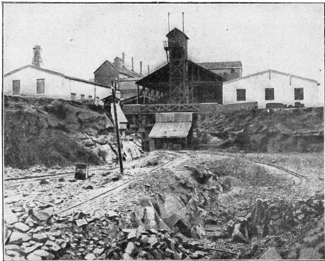
CARRIÈRE ET USINE A CIMENT ARTIFICIEL A CASABLANCA (MAROC)
