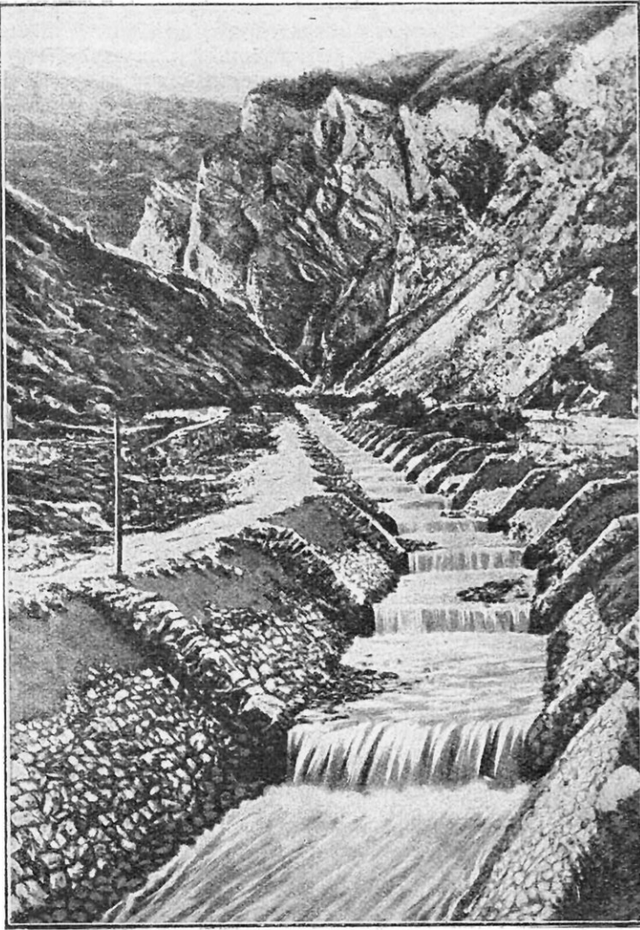
CANALISATION DE SAINT-JULIEN, EN SAVOIE
