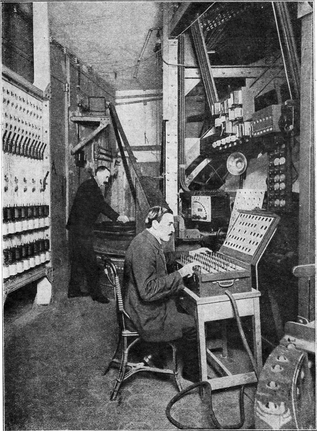
LES EFFETS LUMINEUX SONT OBTENUS A L'AIDE DES TOUCHES QUE MANŒVRE L'ÉLECTRICIEN
