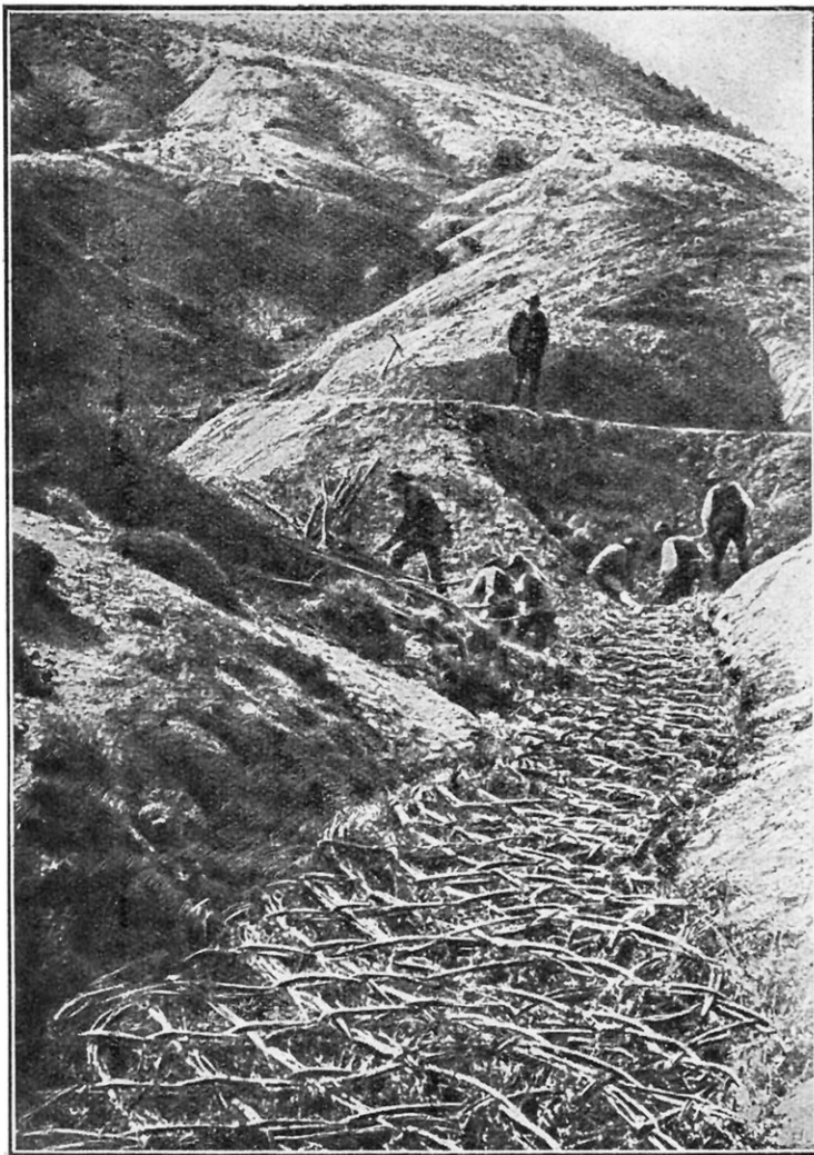
GARNISSAGE D'UN RAVIN DANS LES BASSES-ALPES
