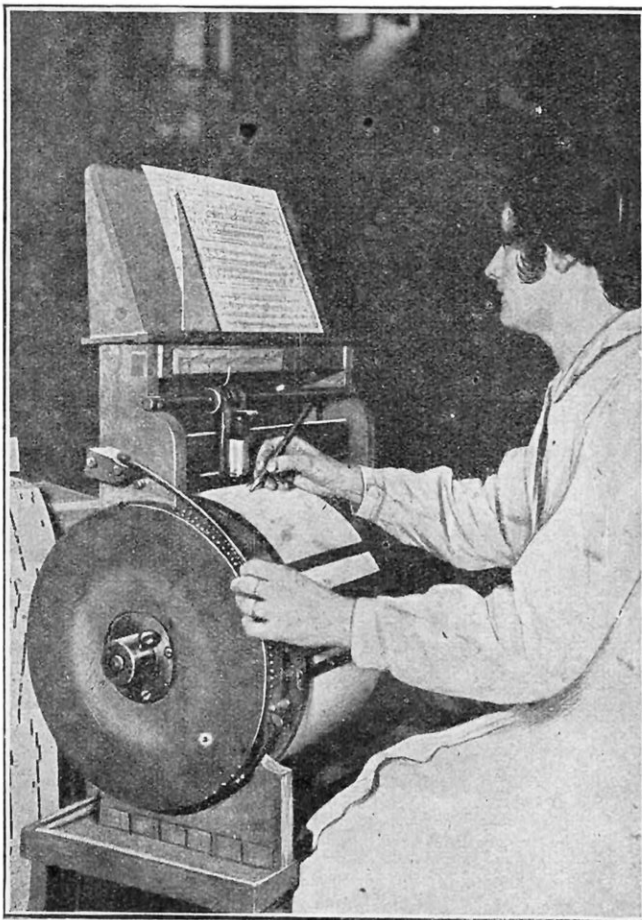
MACHINE SERVANT A TRACER LA MUSIQUE SUR LES BANDES DE CARTON POUR ORCHESTROPHONE
