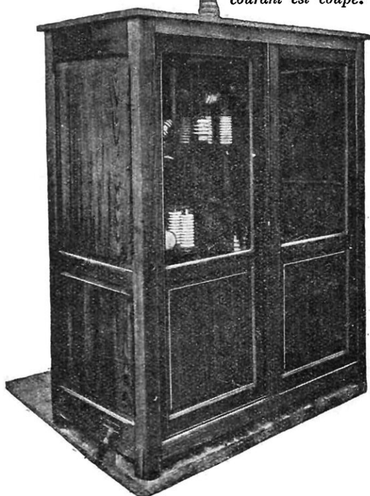
FIG. 4. — ARMOIRE VITRÉE DES APPA- REILS A HAUTE TENSION
