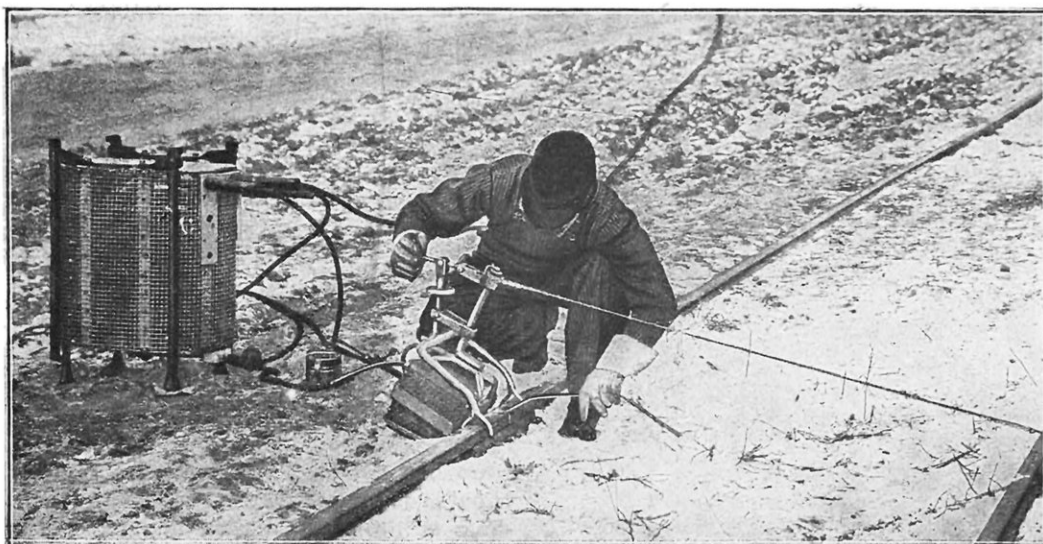
AVEC CE PETIT APPAREIL, UN HOMME SUFFIT POUR EXÉCUTER LES SOUDURES
