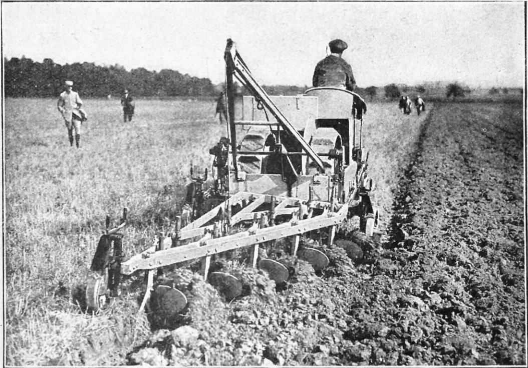
VUE ARRIÈRE D'UNE CHARRUE TOURAND-LATIL A CINQ SOCS
