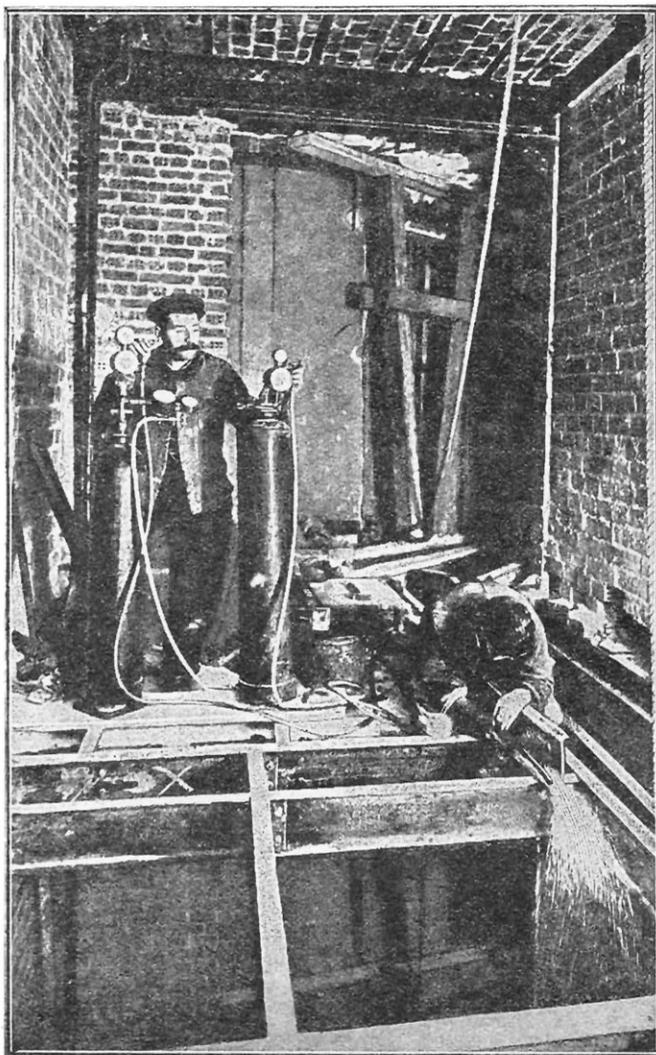
DÉCOUPAGE DES POUTRES DE FER A L'AIDE DU CHALUMEAU OXYDRIQUE
