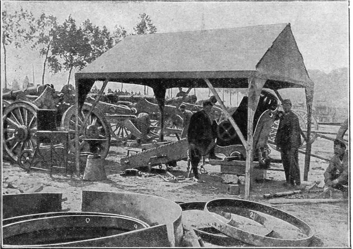
SUR LE FRONT : ATELIERS IMPROVISÉS POUR LA RÉPARATION DES AFFUTS
