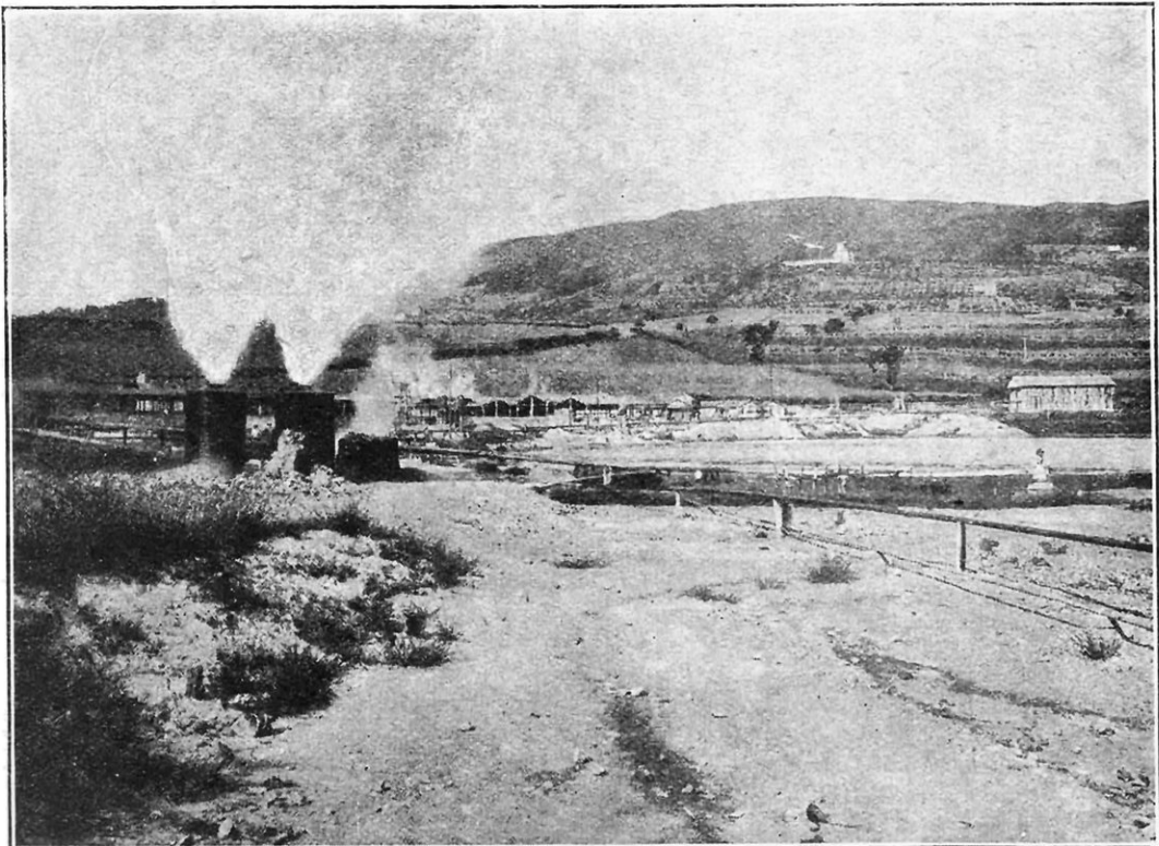
CE « SOFFIONE », VÉRITABLE VOLCAN, DONNE 24.000 KILOS DE VAPEUR PAR HEURE
