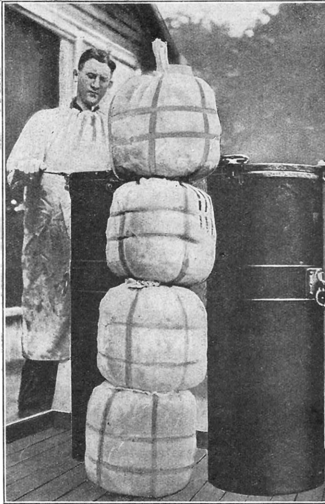
CES QUATRE SACS DE POUDRE NE CONSTITUENT QU'UNE SEULE CHARGE POUR LES CANONS DE 356 MILLIMÈTRES
