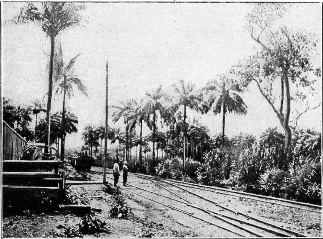
UNE SECTION DE LA VOIE FERRÉE DE LA GUINÉE AU SOUDAN
