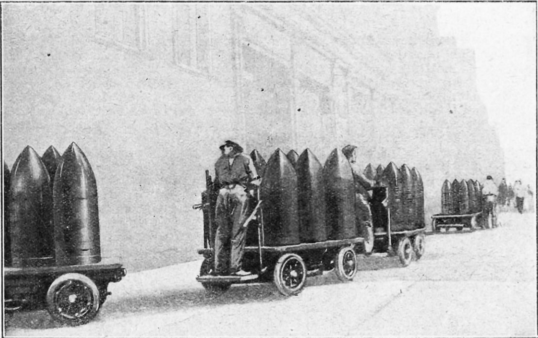
WAGONNETS ÉLECTRIQUES POUR LE TRANSPORT DES GROS OBUS
