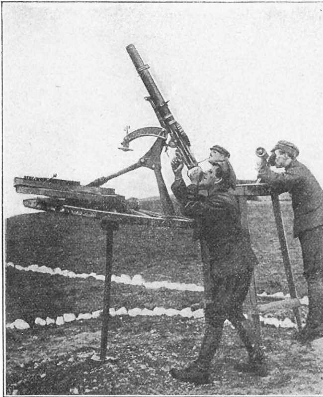
MITRAILLEUSE ANGLAISE LEWIS TIRANT CONTRE AVION Installation de fortune sur une roue de charrette tournant sur son essieu disposé verticalement. Derrière le mitrailleur se tient le télémètre, chargé de lui indiquer les distances de tir.
