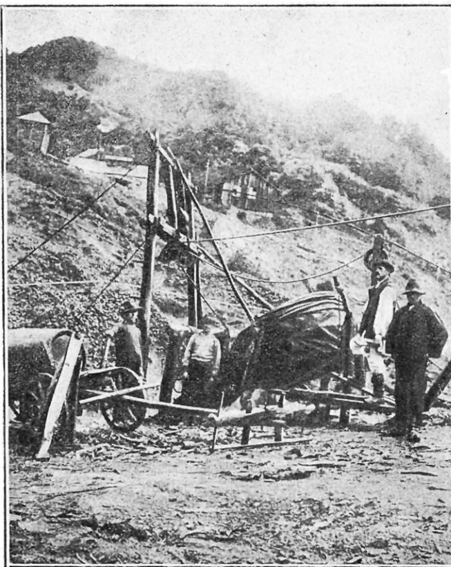
SOUFFLAGE D'UN PUIT ROUMAIN POUR PROVOQUER LA MONTÉE DU PÉTROLE
