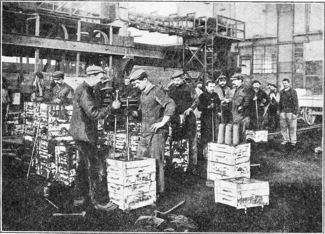
LA FABRICATION DES GROS OBUS DANS UNE FONDERIE DU CENTRE
