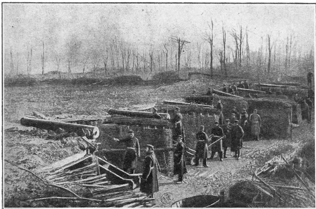
BATTERIE DE CANONS KRUPP DE 12 CENTIMÈTRES INSTALLÉE A L'ORÉE DU BOIS DE MEUDON
