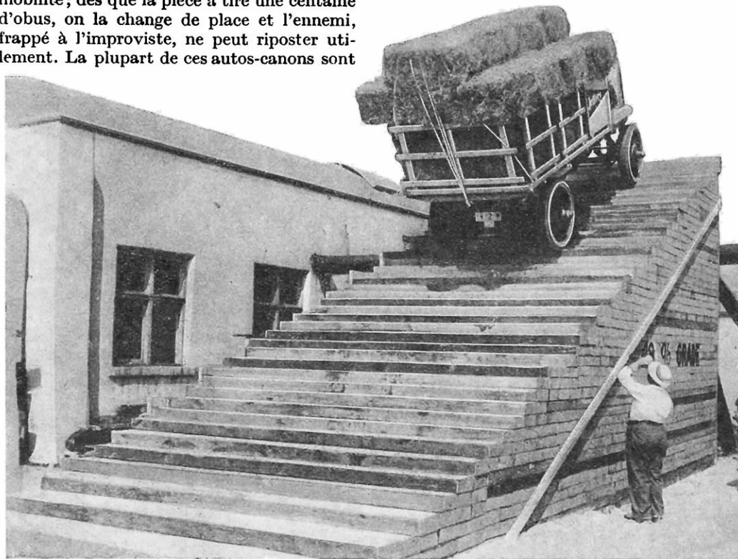
ESSAI D'UN CAMION AMÉRICAIN SUR UNE RAMPE-ESCALIER INCLINÉE A 49 °/o
