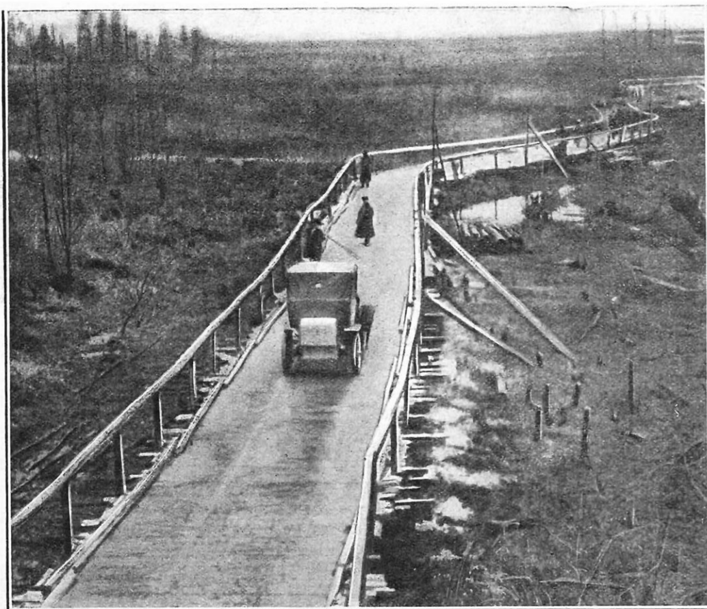
PONT DE BOIS DE 500 MÈTRES CONSTRUIT PAR LES ALLEMANDS AU-DESSUS D'UN MARAIS
