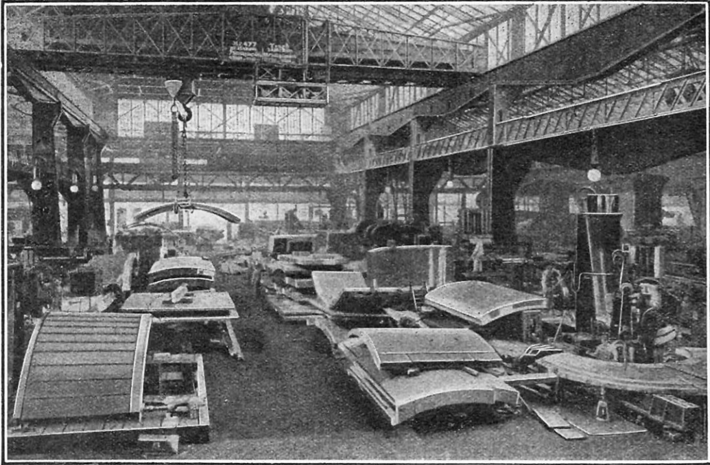
ATELIER DE FINISSAGE DES PLAQUES DE BLINDAGE POUR CUIRASSÉS
