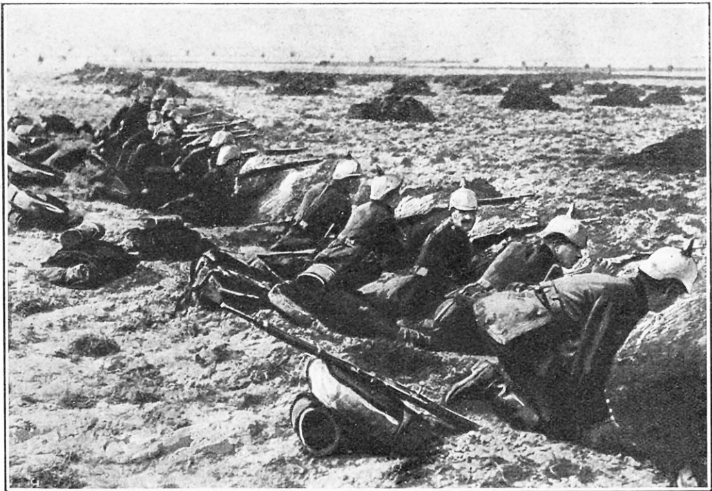
TRANCHÉE-ABRI DE PREMIÈRE LIGNE CREUSÉE PAR UNE SECTION D'INFANTERIE ALLEMANDE
