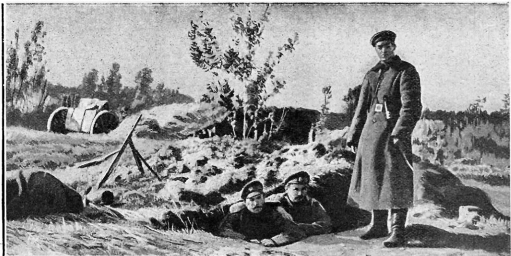
TRANCHÉES ABRITANT DES FANTASSINS RUSSES EN ARRIÈRE DE GUMBINNEN
