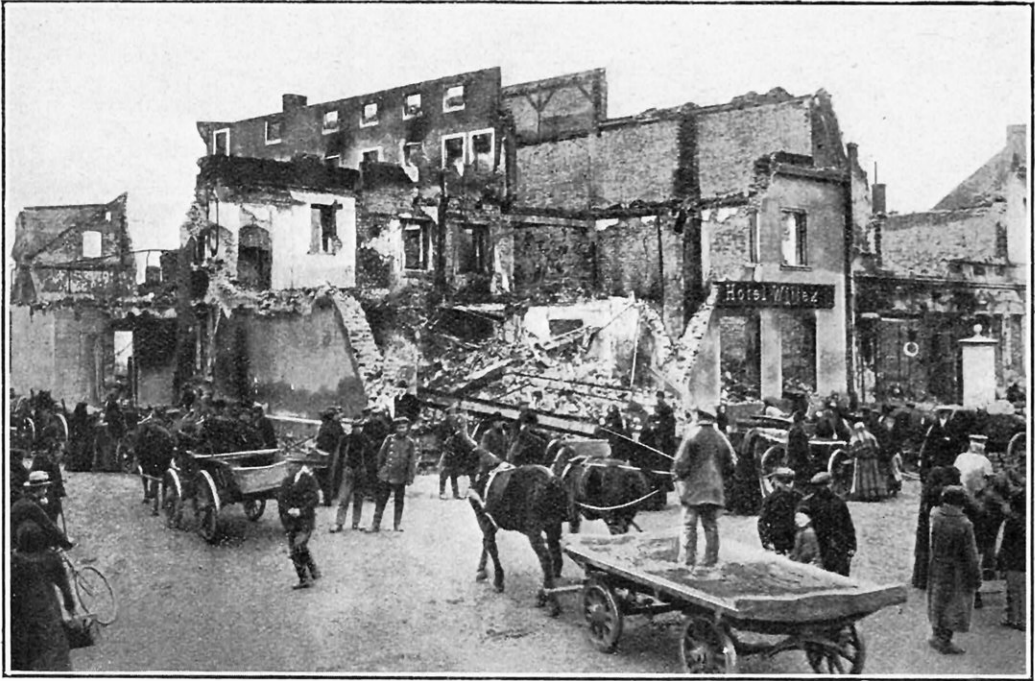
UN COIN TRAGIQUE DE LA VILLE DE WIDAWA APRÈS LA RETRAITE ALLEMANDE Le système des Teutons est partout le même: ils incendient les villes où ils ne peuvent se maintenir.
