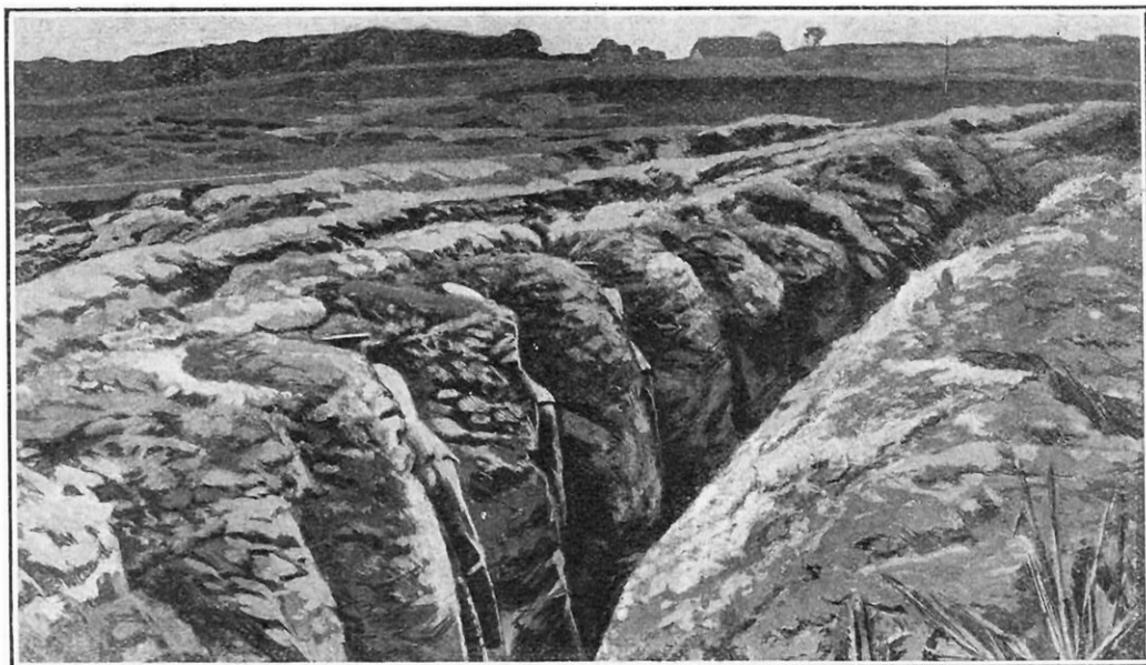
TRANCHÉE RUSSE A COMPARTIMENTS INDIVIDUELS SERVANT A PROTÉGER LES HOMMES CONTRE LES FEUX D'ENFILADE ET LE TIR FAUCHANT
