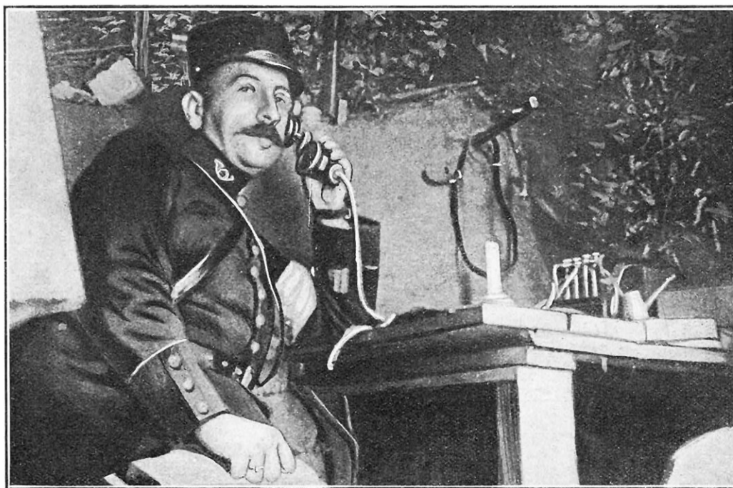
POSTE TÉLÉPHONIQUE DANS UNE TRANCHÉE COUVERTE (FRONTIÈRE DE L'EST)
