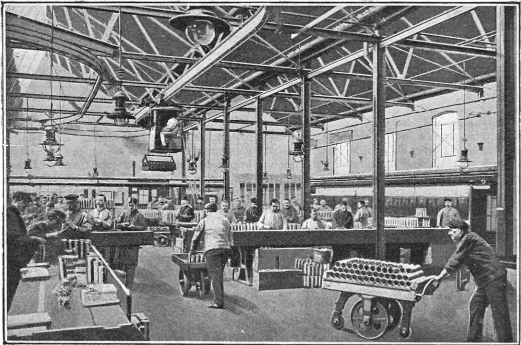
LA VÉRIFICATION DU CALIBRE DES OBUS DANS L'ATELIER DES PROJECTILES
