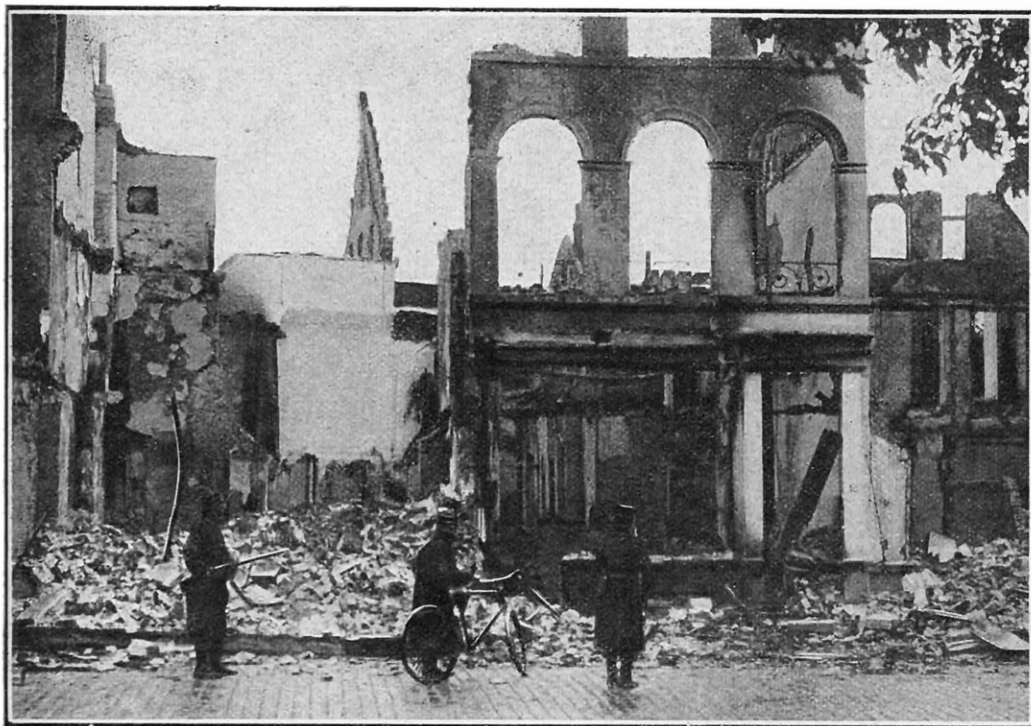
MAISONS INCENDIÉES DANS L'UNE DES PRINCIPALES RUES DE TERMONDE
