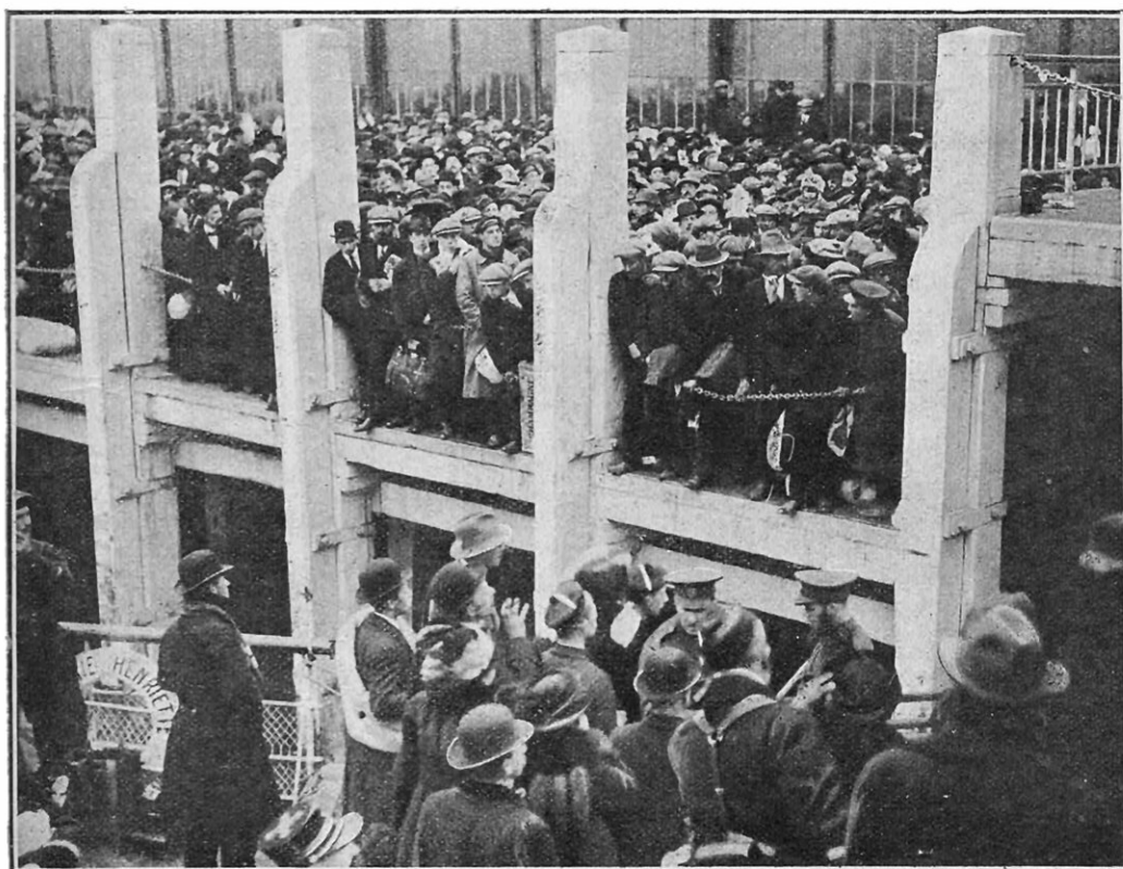
LE PONTON D'EMBARQUEMENT DES VAPEURS POUR OSTENDE Dès qu'ils arrivent à quai, les bateaux se remplissent de fugitifs, tellement sont nombreux ceux qui veulent se soustraire aux horreurs du bombardement.
