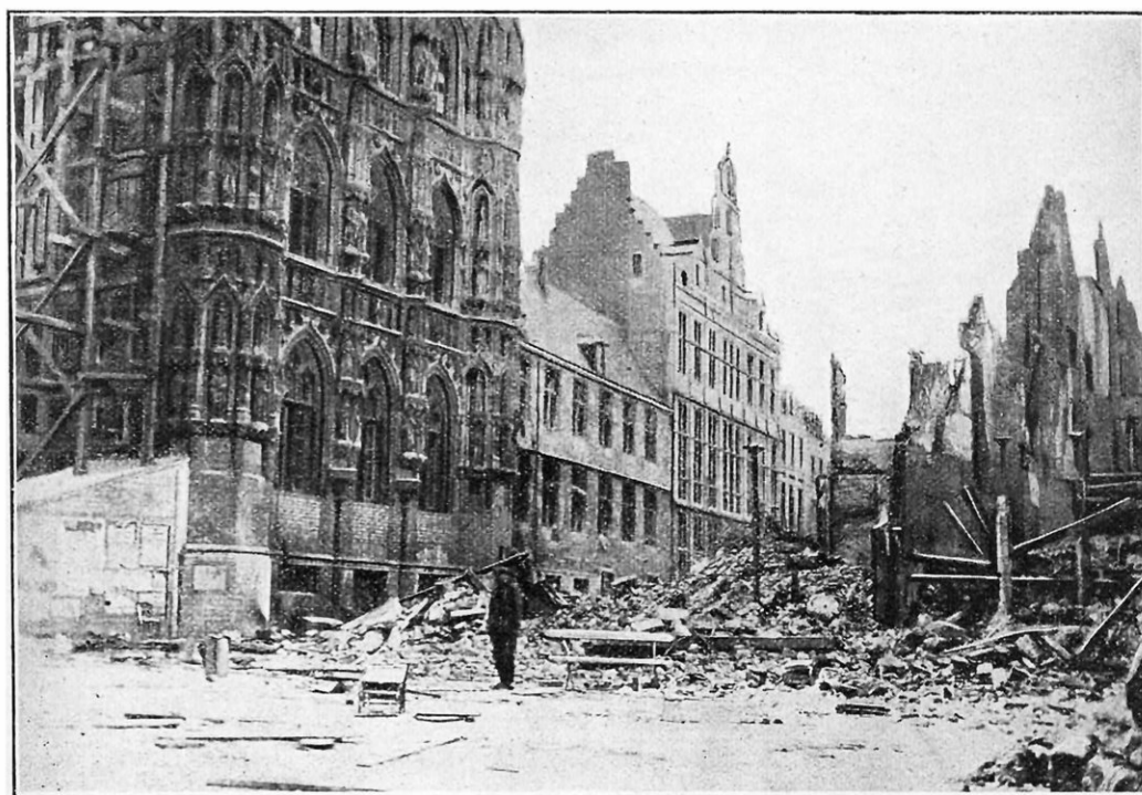
CE QUI RESTE AUTOUR DE L'HOTEL DE VILLE, HEUREUSEMENT SAUVEGARDÉ
