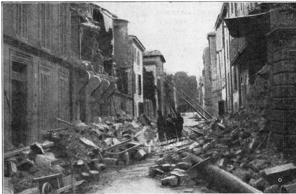
QUELQUES TRACES DU DERNIER TREMBLEMENT DE TERRE DE PROVENCE (11 JUIN 1909) A Salon, les maisons de la rue d'Avignon avaient fortement souffert : les murs qui ne s'étaient pas écroulés eurent être étayés pour maintenir leur équilibre incertain.
