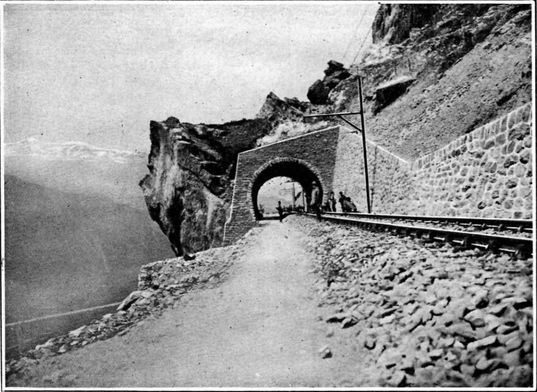
TRAVAUX DE PROTECTION CONTRE LES AVALANCHES ET LES ÉBOULIS AU SUD DU TUNNEL
